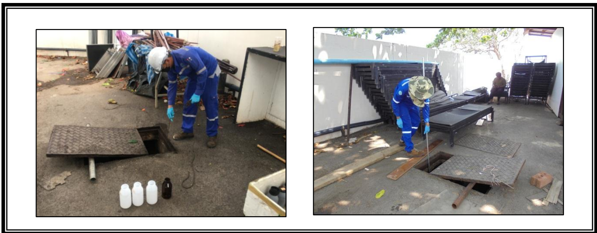
รูปที่ 3.1-6 จุดตรวจวัดคุณภาพน้ำทิ้ง บริเวณน้ำทิ้งหลังบำบัด (Effluent Tank) ระบบบำบัดน้ำเสีย อาคารร้านอาหาร ประจำเดือนมกราคม - มิถุนายน พ.ศ. 2566
